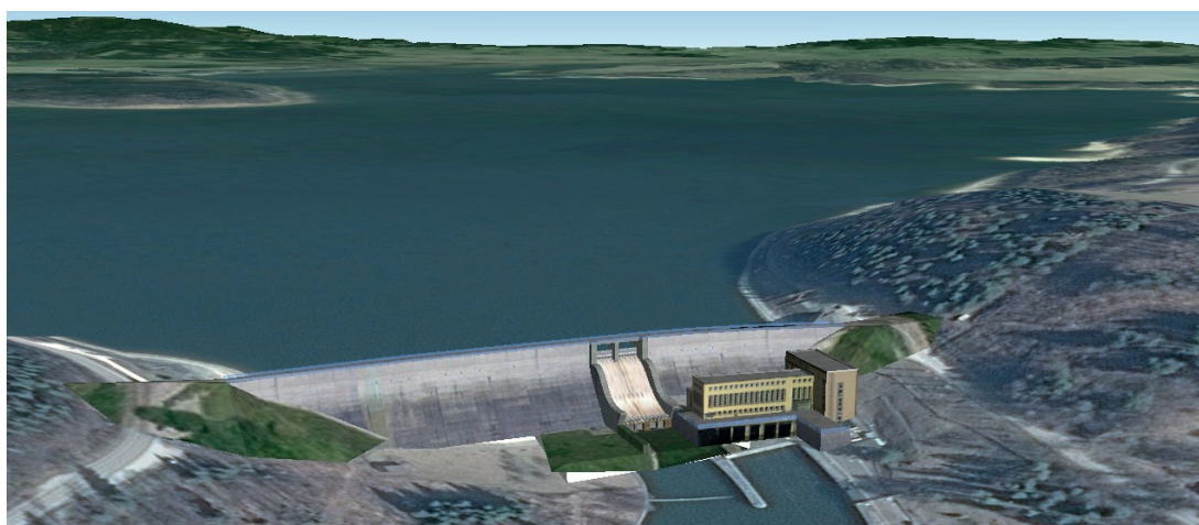
Obr. 2. Súčasný pohľad na priehradný múr a vodnú plochu za ním (zdroj Google Earth).
